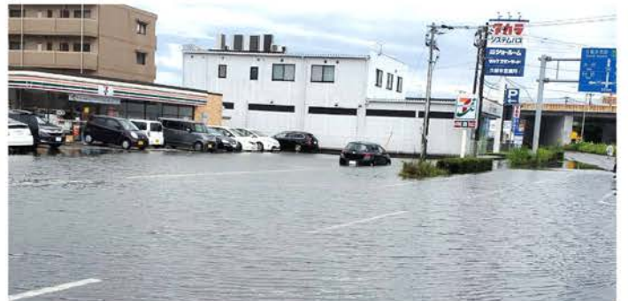
久留米市ゆめタウン前の210号線バイパス前の冠水②
