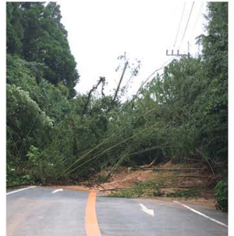
大牟田市内向かう県道10号線上内峠が土砂崩れで道路寸断
